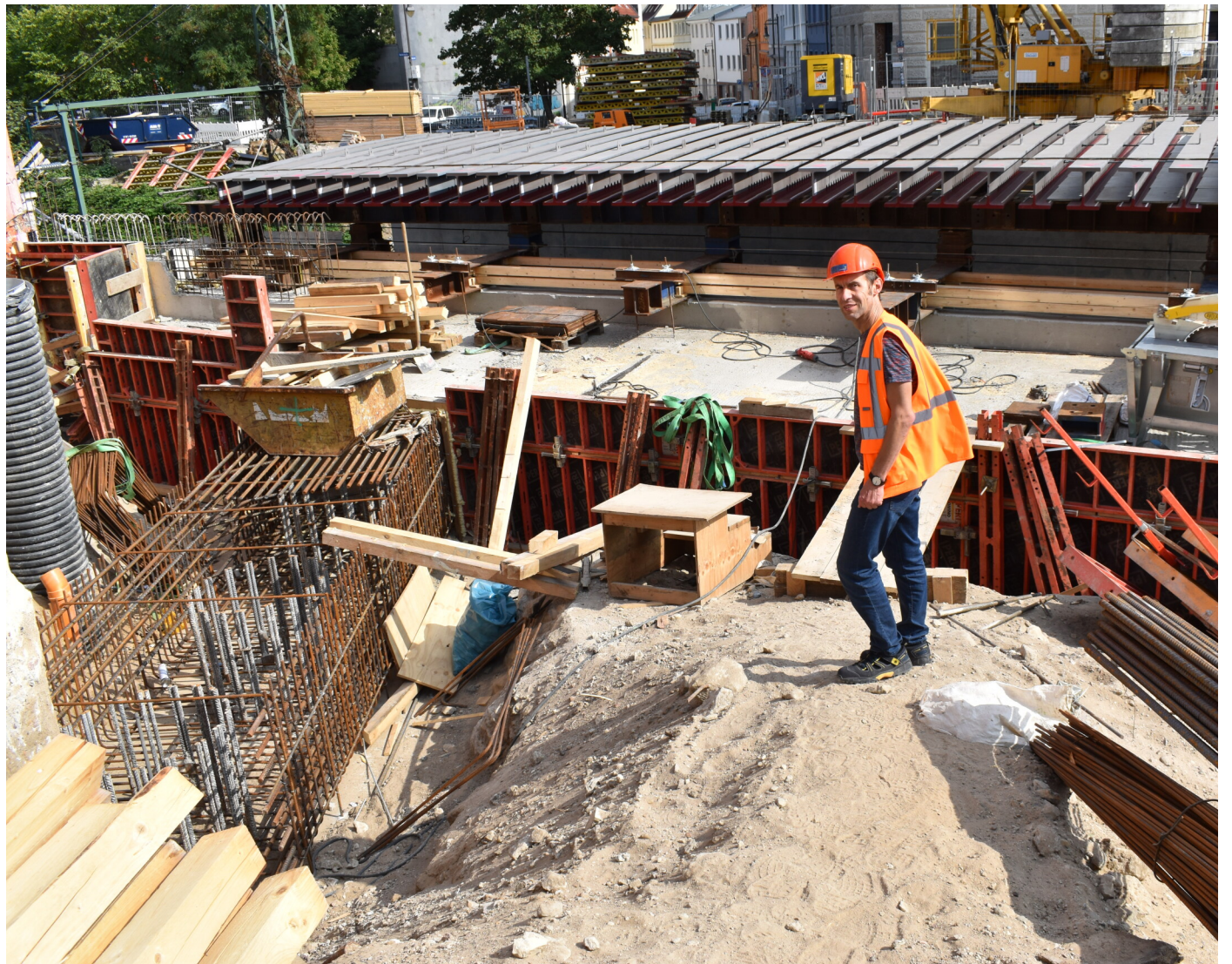
Bauleiter Jörg Herrmann ist zufrieden: Das Einsetzen der 33 Doppel-T-Träger für den Brückenüberbau hat perfekt funktioniert. Foto: Schüttpelz
