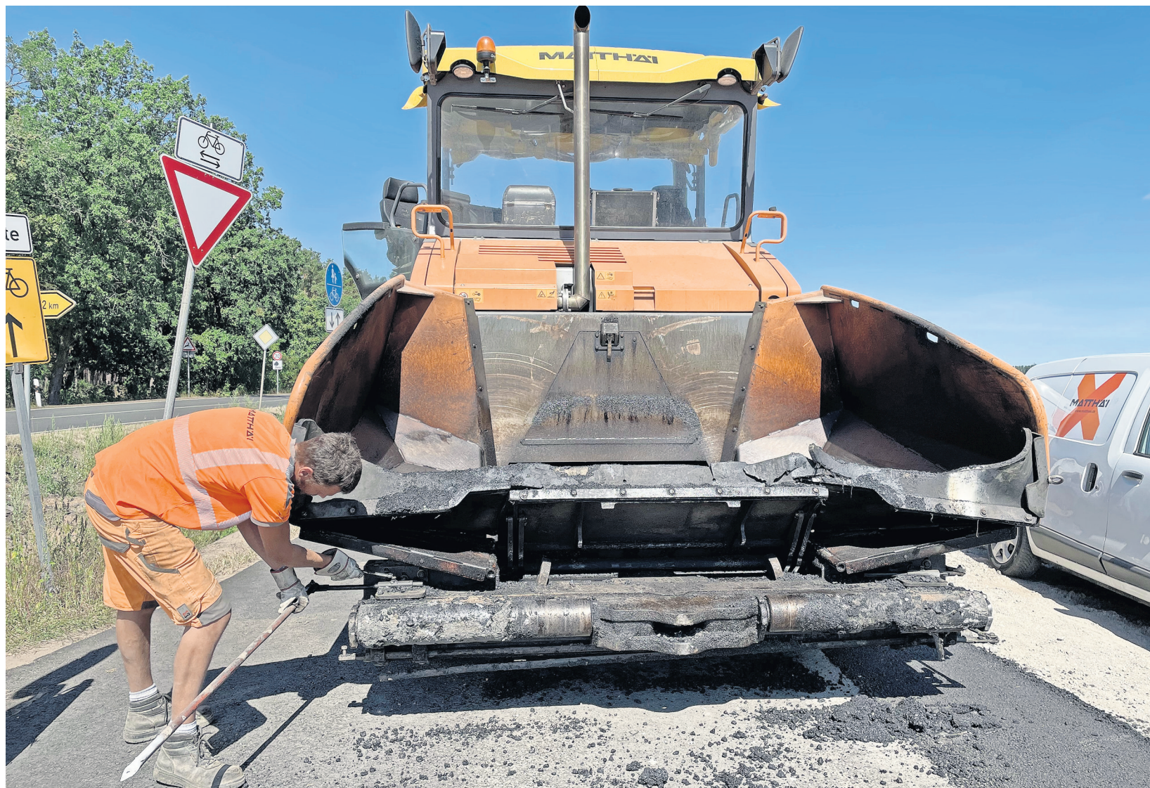
Erneuerung des Radweges an der B102 zwischen Dippmannsdorf und Schwanebeck: Christian Heß bereitet das Asphaltieren vor.
